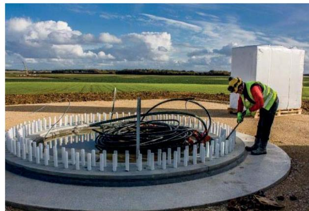
Figure 7: Aspect d'une fondation en cours de chantier
